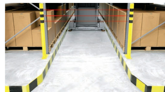
Stasjonært personlig verneutstyr med lysbarrierer i utvalgte reolganger
